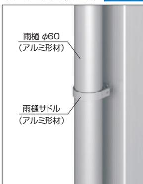
破損しにくいアルミ製の雨樋とサドルです。
